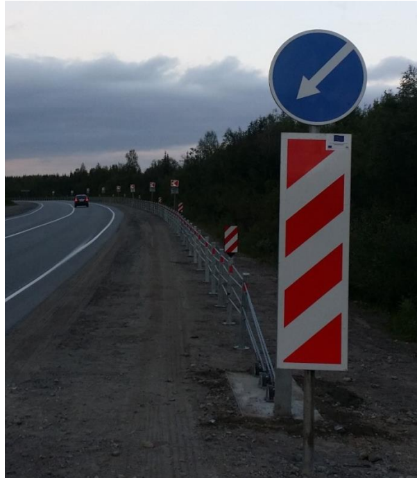
Рисунок 15– Установка тросового ограждения на обочине
