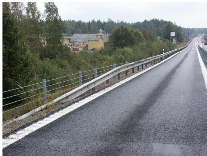
Рисунок 11 – Переходный участок тросового ограждения
