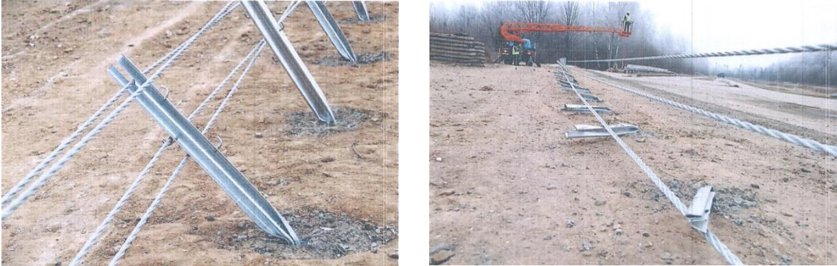
Рисунок 6 – Деформация открытых стоек
