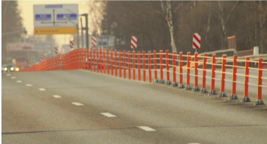
Рисунок 17 - Установка тросового ограждения на мостовом сооружении
