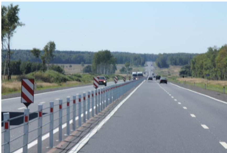
Рисунок 16 - Установка тросового ограждения на оси проезжей части
