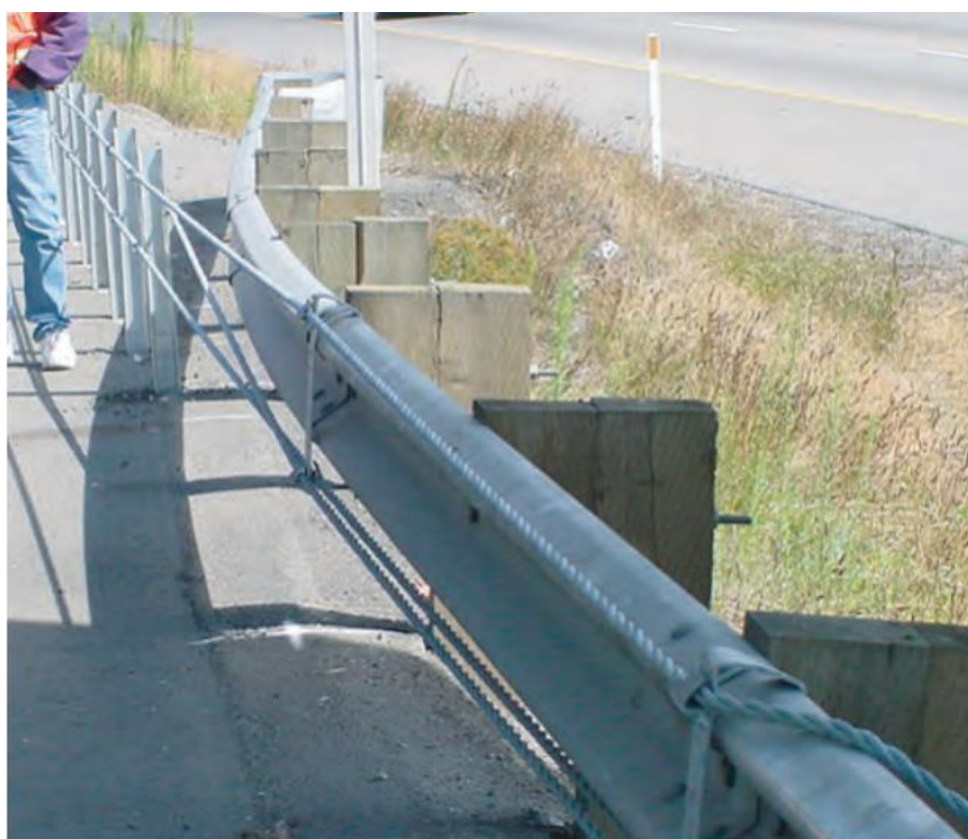
Рисунок 9 – Переходный участок ограждения
