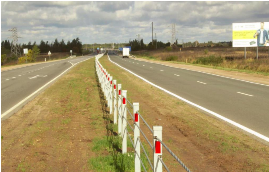
Рисунок 18 - Установка тросового ограждения на разделительной полосе
